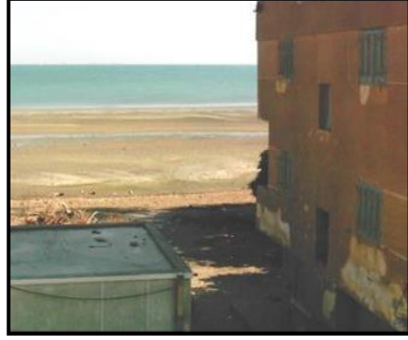
صورة رقم «٨»: سقوط مواد الطلاء نتيجة لنشاط التجوية الملحية
