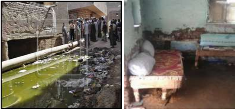
صورة (١٥) تاثر المنازل بتجوية الجدران نتيجة ارتفاع مستوى المياه الارضية بقرية النمسا
