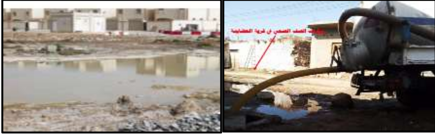
صورة (١٤) ارتفاع المياه الجوفية وعمليات النزح البيارات
